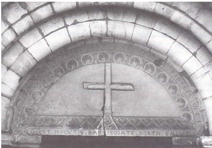
Das Tympanon über dem Westportal im heutigen Zustand (Foto: Enkelmann)
